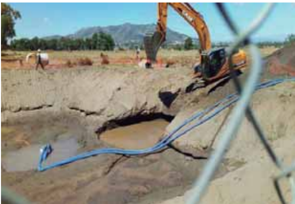
Fig. Obras de construcción y destrucción en Arraijanal
