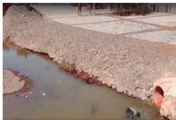
Fig. Vertido de aguas residuales junto a la zona peatonal en El Médano.
