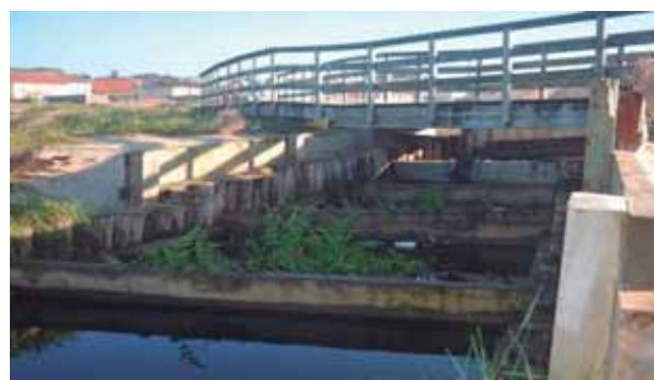
Fig. Canalización del río Paxariños
