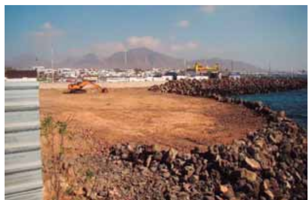
Fig. Obras portuarias
