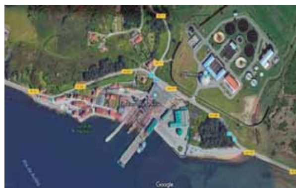
Fig. Vista superior de la depuradora de Maqua
