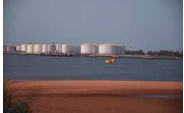
Fig. Depósito de gas en la ría de Huelva
