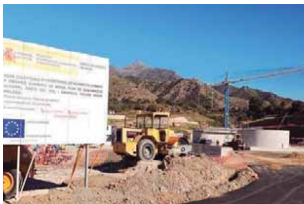
Fig. EDAR de Nerja en obras
